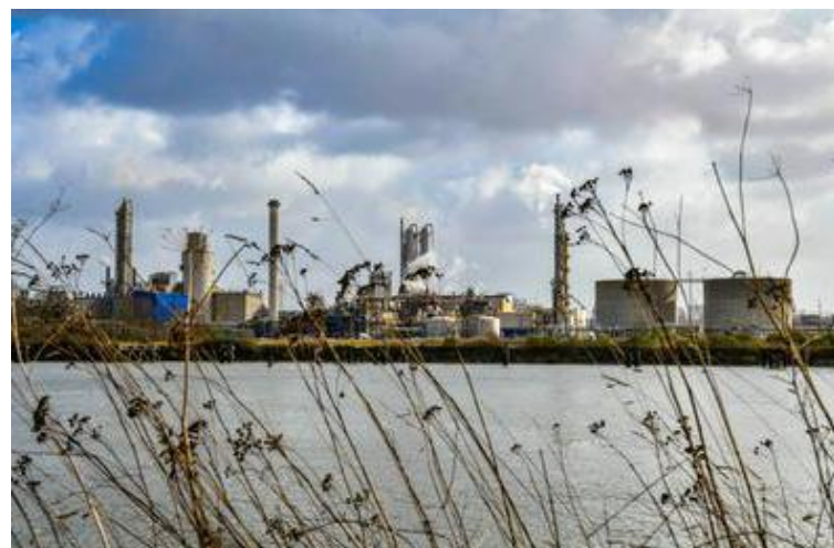
Quel que soit le scénario, la zone industrielle et ses sites Seveso seuil haut sont clairement menacés à l'horizon 2100 Photo STEPHANIE PÉRON
