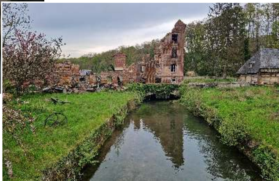
Le moulin de Blainville-Crevon, plus d'un an et demi après l'incendie
