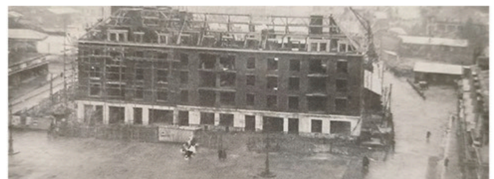
La ville de Lisieux a été reconstruite en environ dix ans. Ici, une image de la place Thiers, alors en plein chantier. Société historique de Lisieux (SHL)
